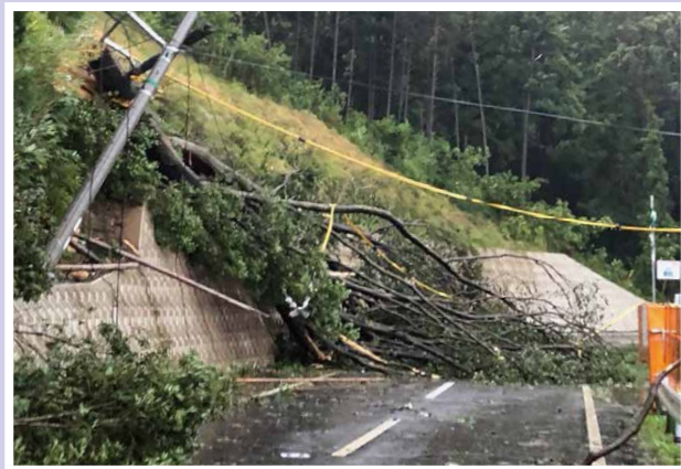
平成30年台風21号倒木被害
