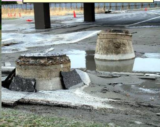
地盤沈下しマンホールが飛び出した
